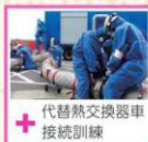
+ 代替熱交換器車接続訓練
