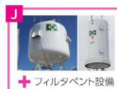
+ フィルタベント設備
