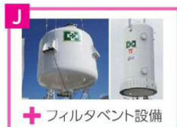
+ フィルタベント設備 格納容器内の蒸気をフィルタを通して大気へ放出する設備。これにより、ヨウ素は1/50以下、セシウム等の粒子は1/1000以下まで低減して放出します。
